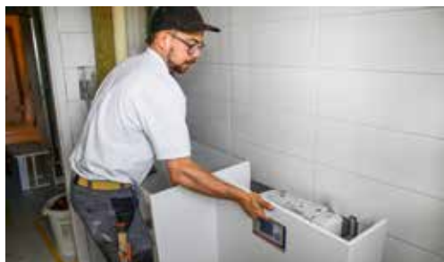
Vorwand und Möbel werden im Werk bereitgestellt, auf die Baustelle geliefert und dort montiert (im Uhrzeigersinn von links). Innert zehn Arbeitstagen können so 24 Bäder erneuert werden.
